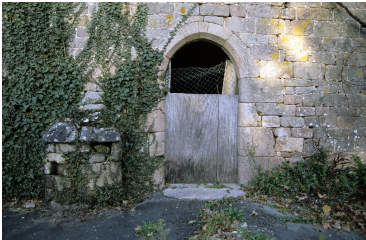
Elévation sud, vue générale.
