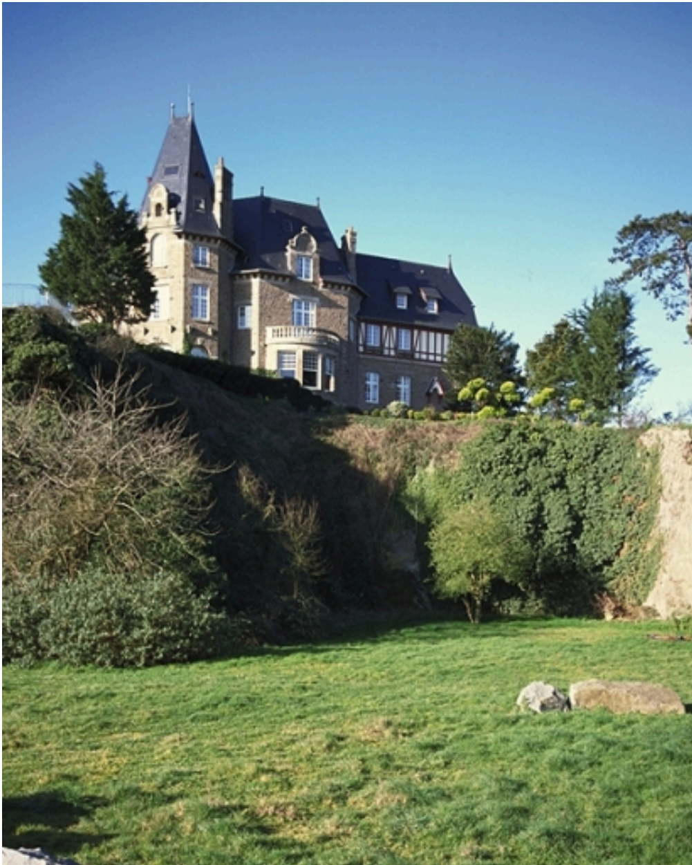
Vue générale nord ; ancienne carrière au premier plan
