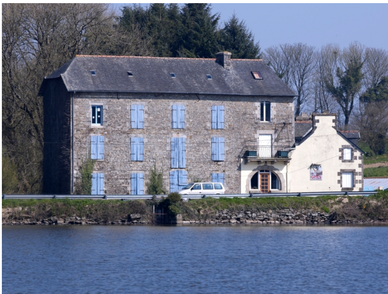
Loguivy-Plougras, Beffou : ancien moulin aujourd'hui gîte, vue sud
