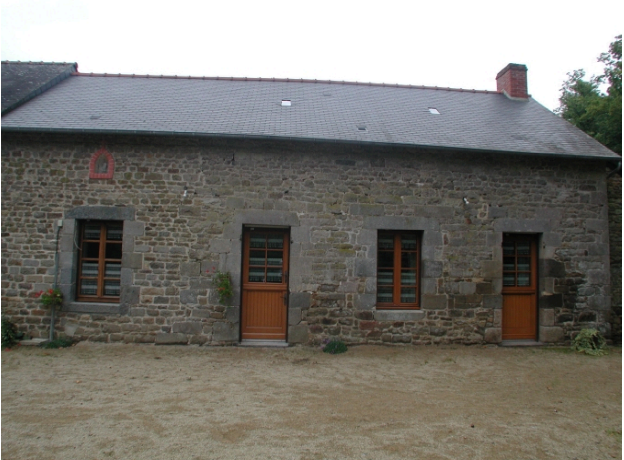
Ferme ; détail du corps de logis remanié en 1931
