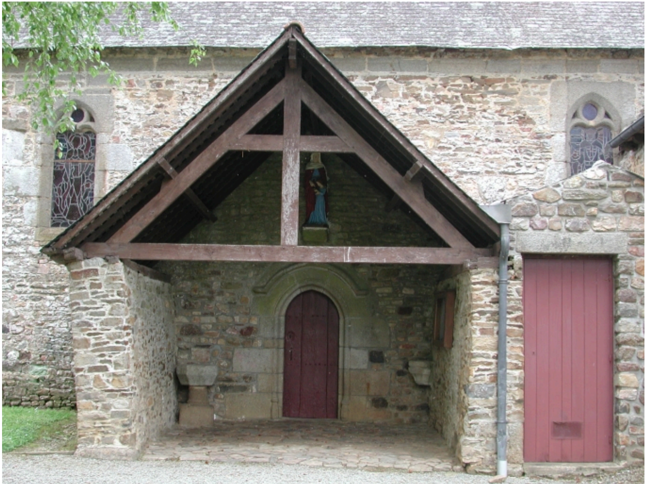
Façade sud : détail du porche
