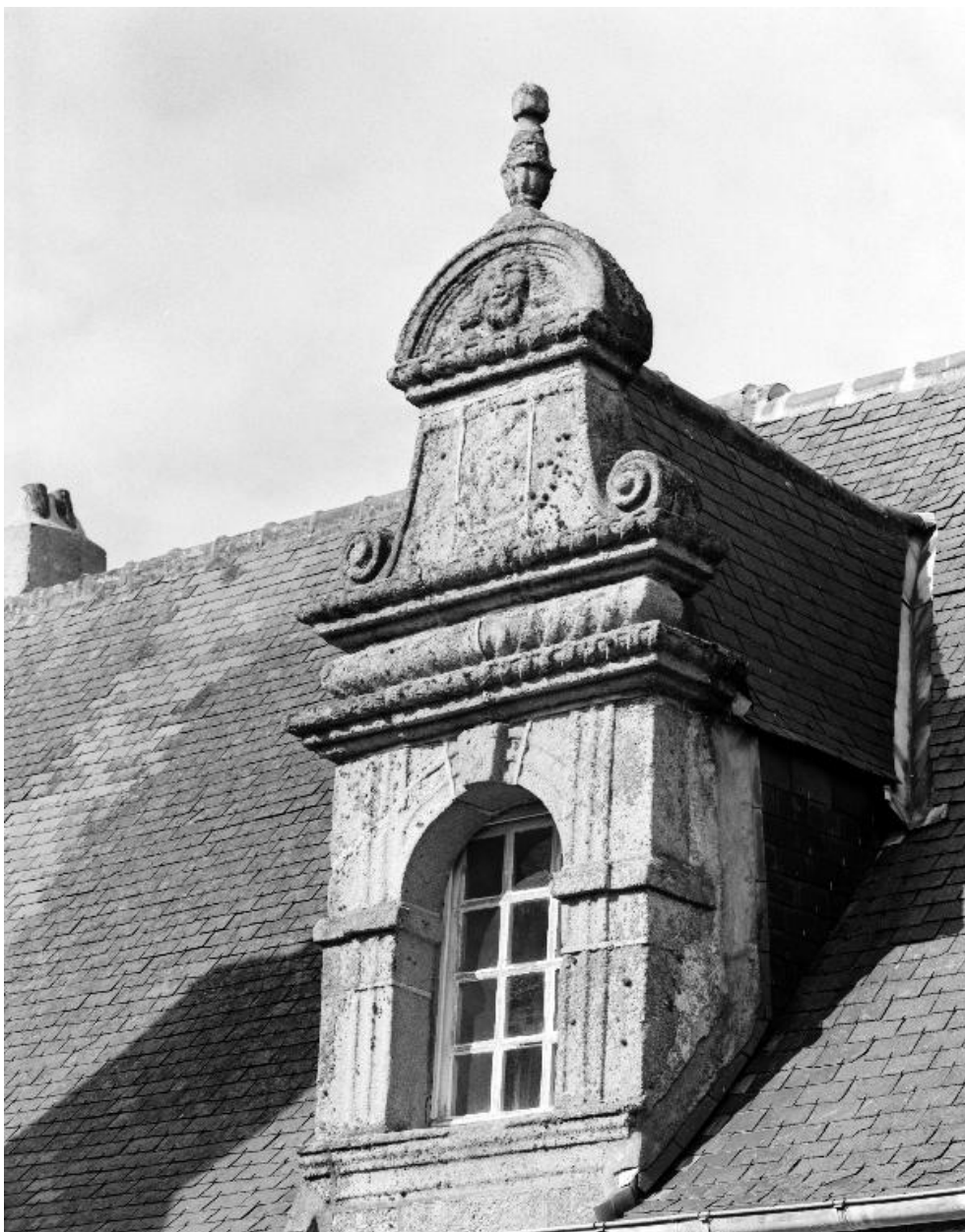
Rue des Moguerou, logis : détail de la lucarne
