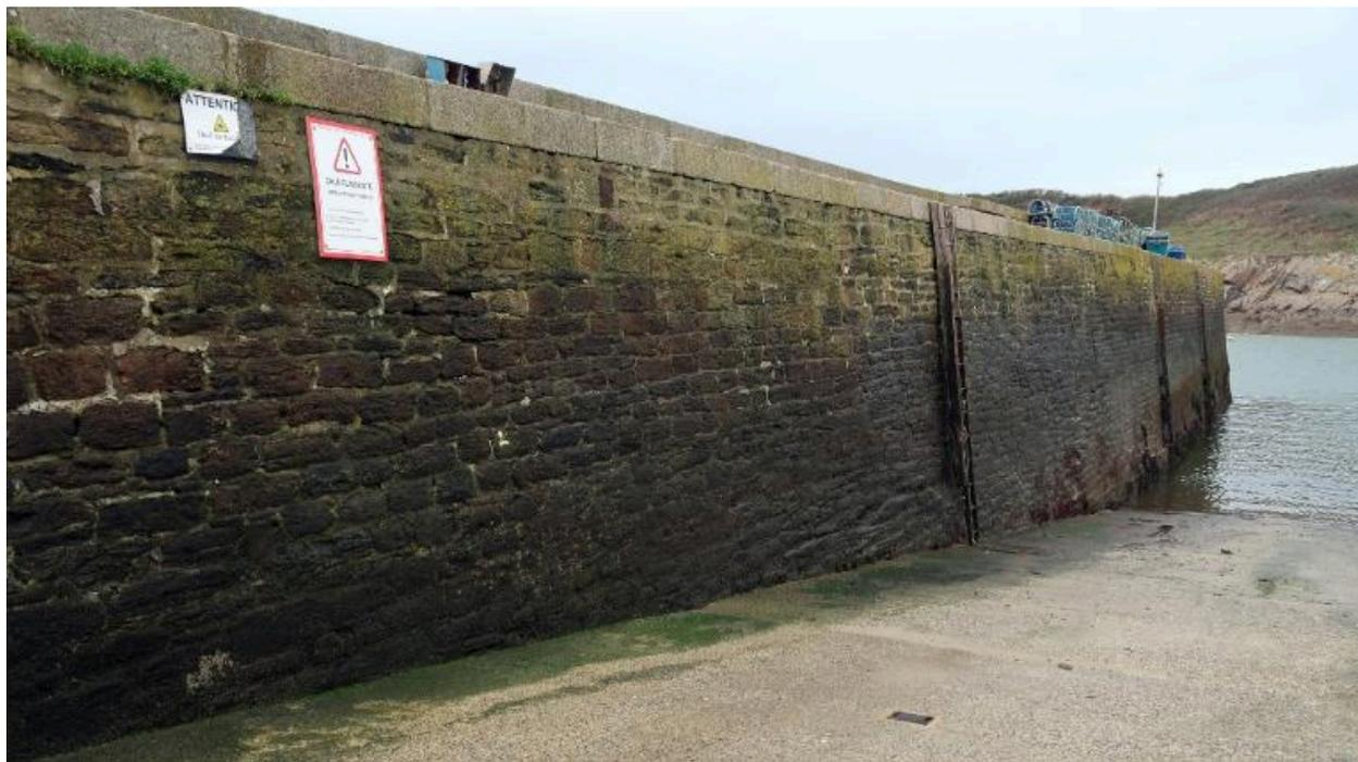
Môle Saint-Christophe : massif poids en maçonnerie (mortier de ciment et chaux), échelles
