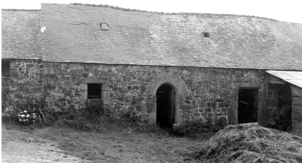
Maison (Lestern) : vue de la face antérieure
