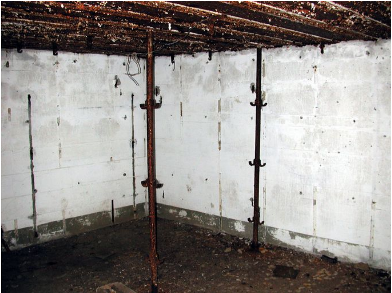
Landéda, île Cézon : abri pour un groupe de type 501 du fort Cézon, vue intérieure. Les supports des couchettes tubulaires sont encore en place
