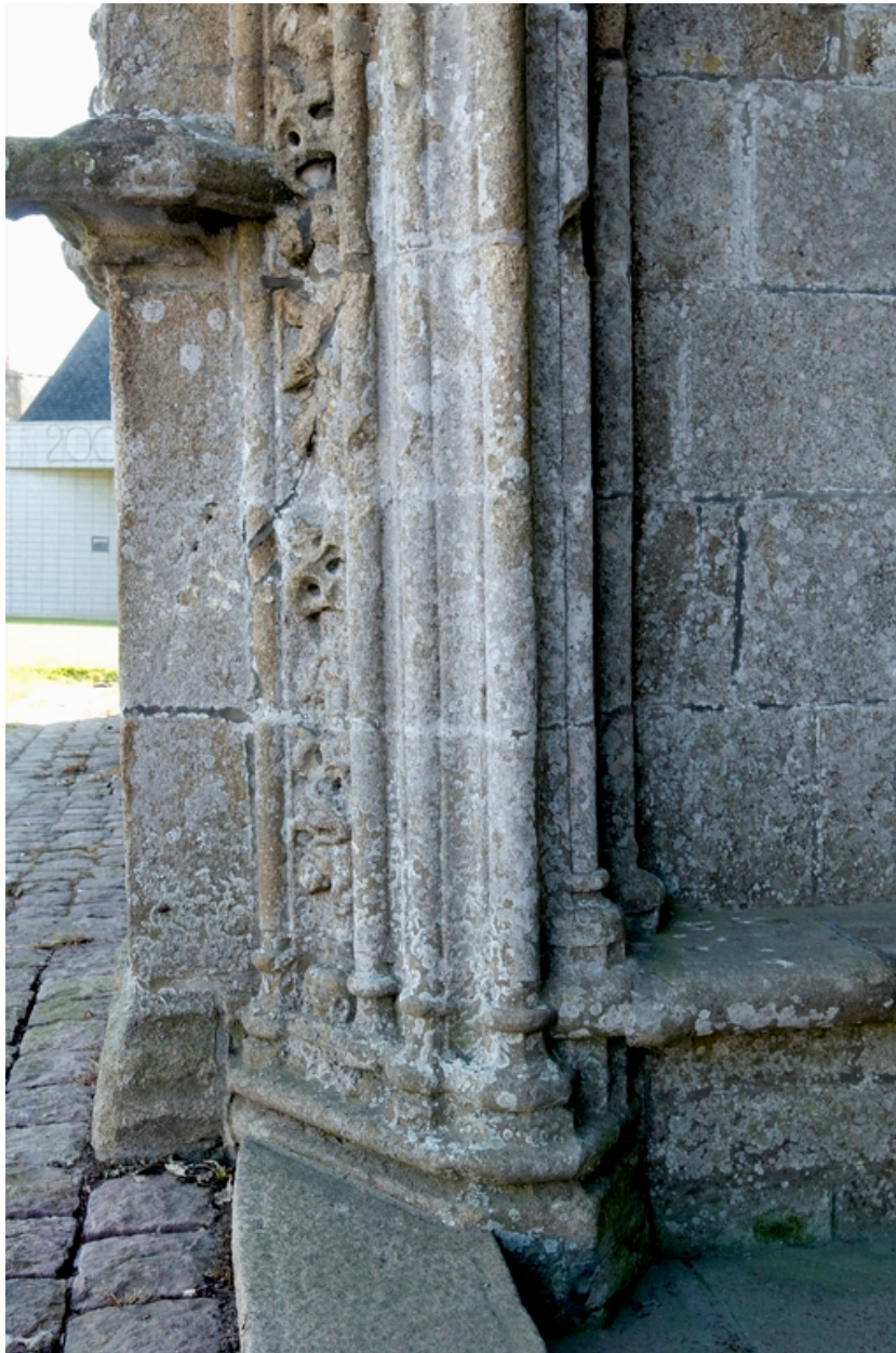
Porche nord ébrasement gauche de l'arc d'entrée.
