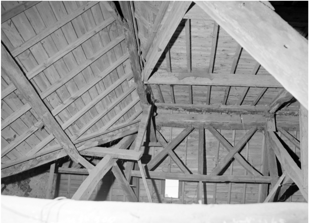
Charpente, étrésillonnement du sous-faîtage en croix de St-André (état en 1978).
