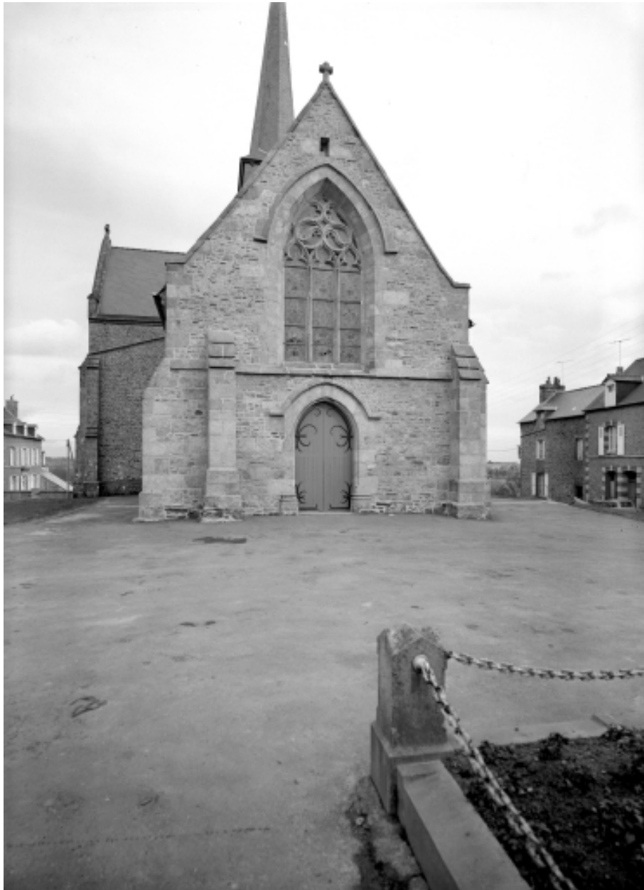
Elévation Ouest : vue générale
