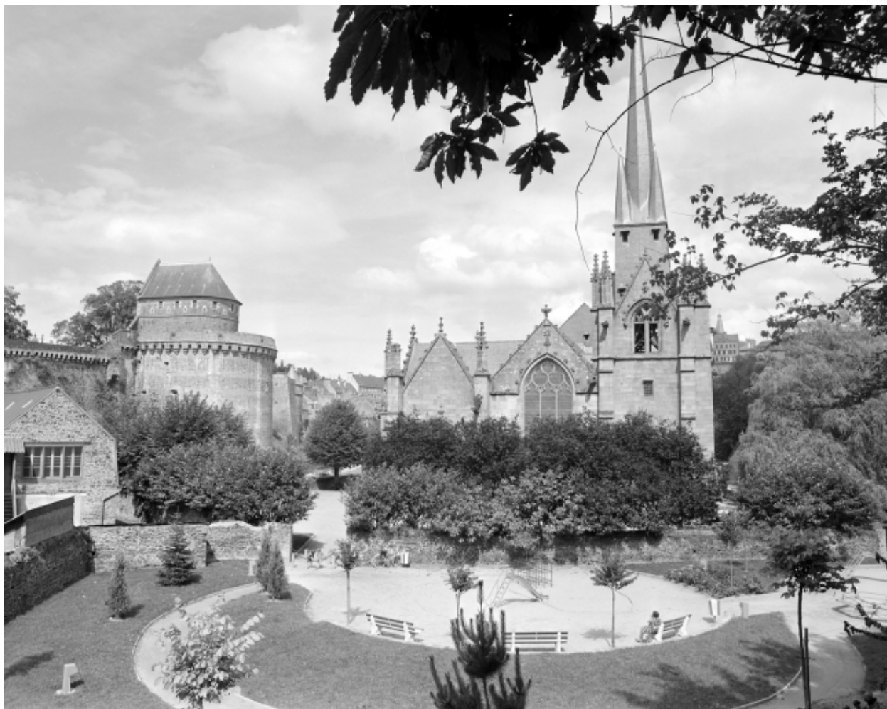
Vue de situation prise de l'ouest.
