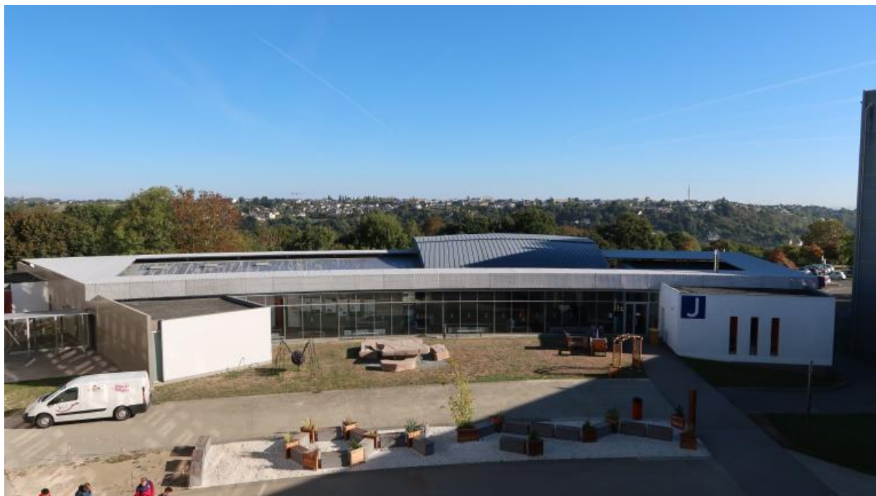
Vue d'ensemble du bâtiment J (CDI, salle des professeurs, amphithéâtre), prise depuis le sud. Thierry Soquet, architecte, 2006.
