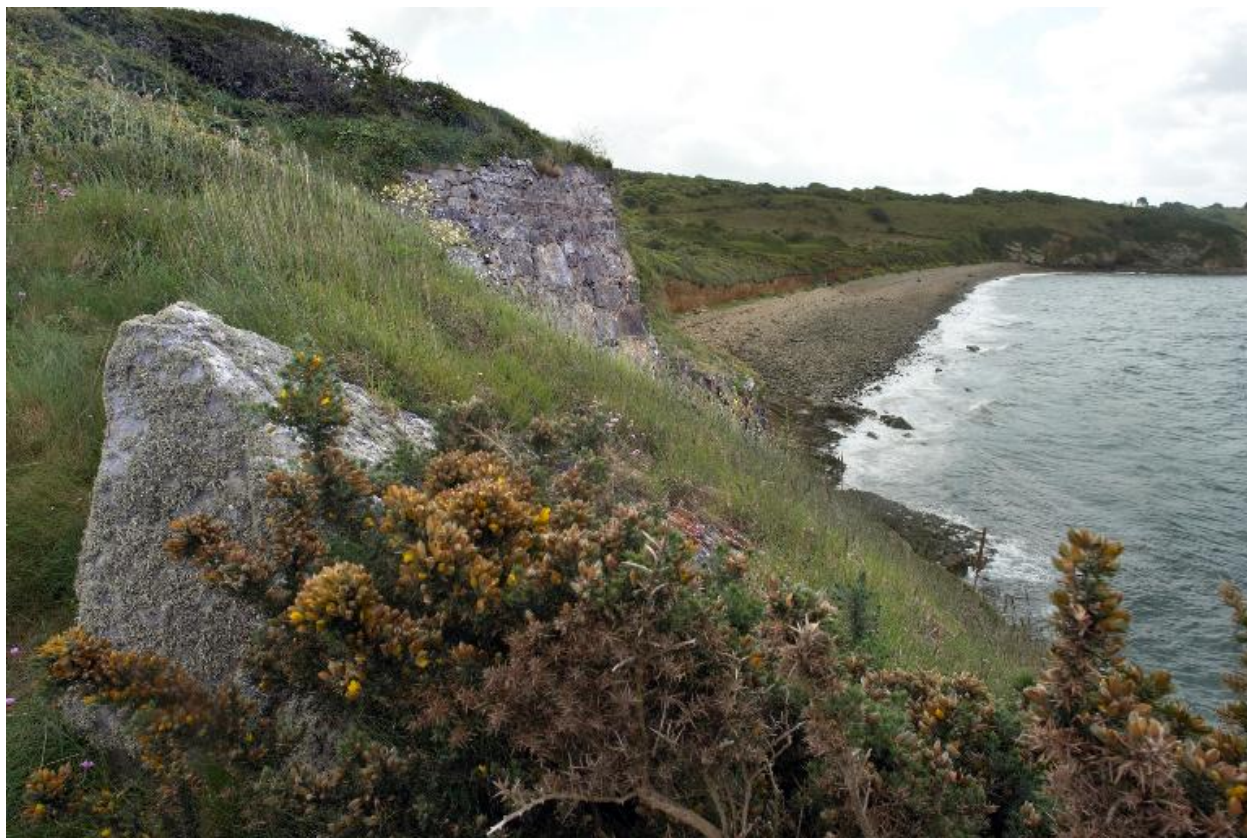
Vue de la batterie basse : mur de soutènement du parapet (état en 2009)
