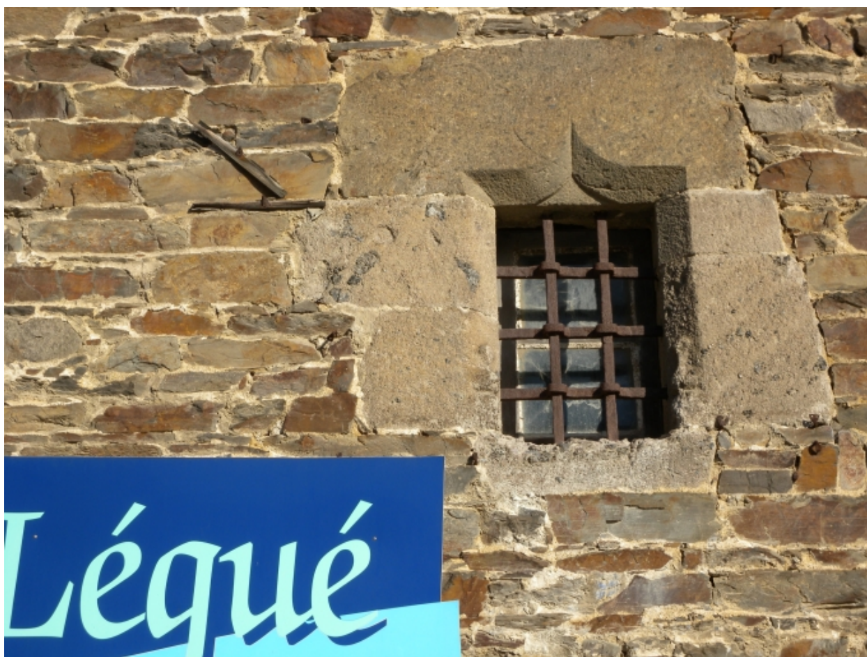
Vue de détail d'une petite ouverture en anse de panier, fermée par une grille en fer forgé
