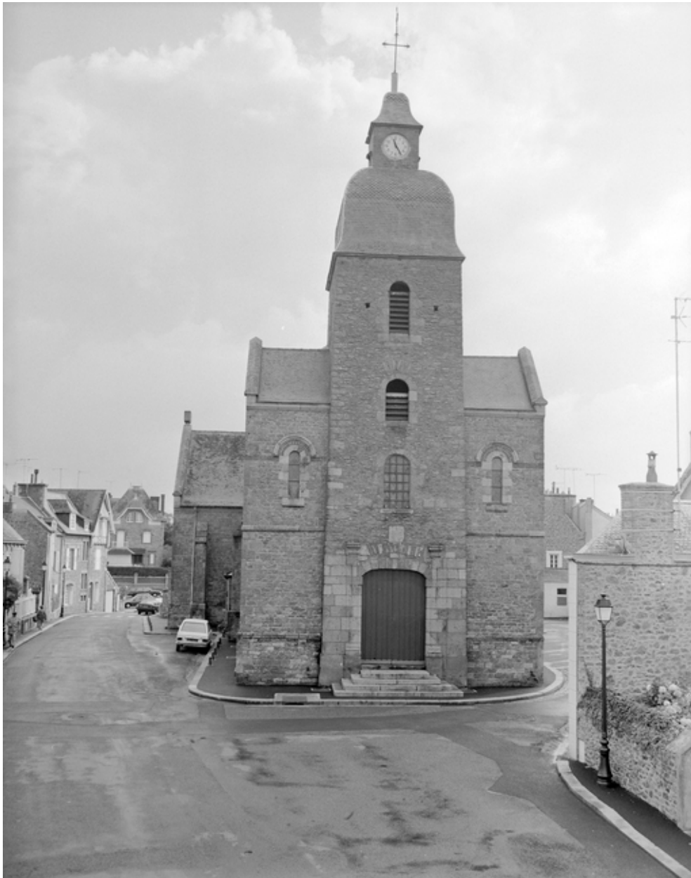
Elévation Ouest : vue générale.
