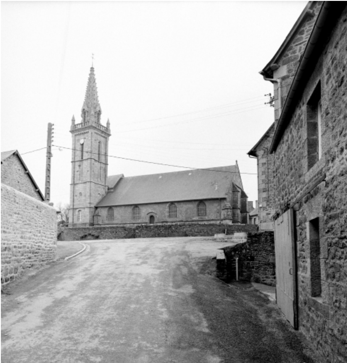
Elévation Nord : vue générale
