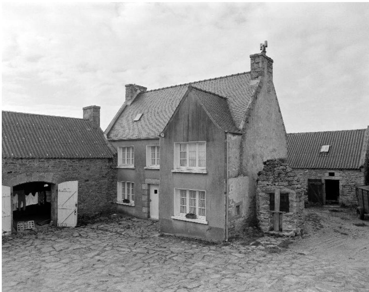
Praterou, Ferme : élévation sud, vue générale
