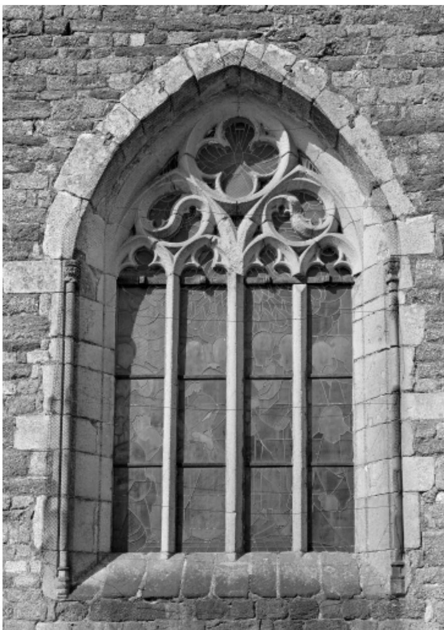
Façade sud, baie, vue générale
