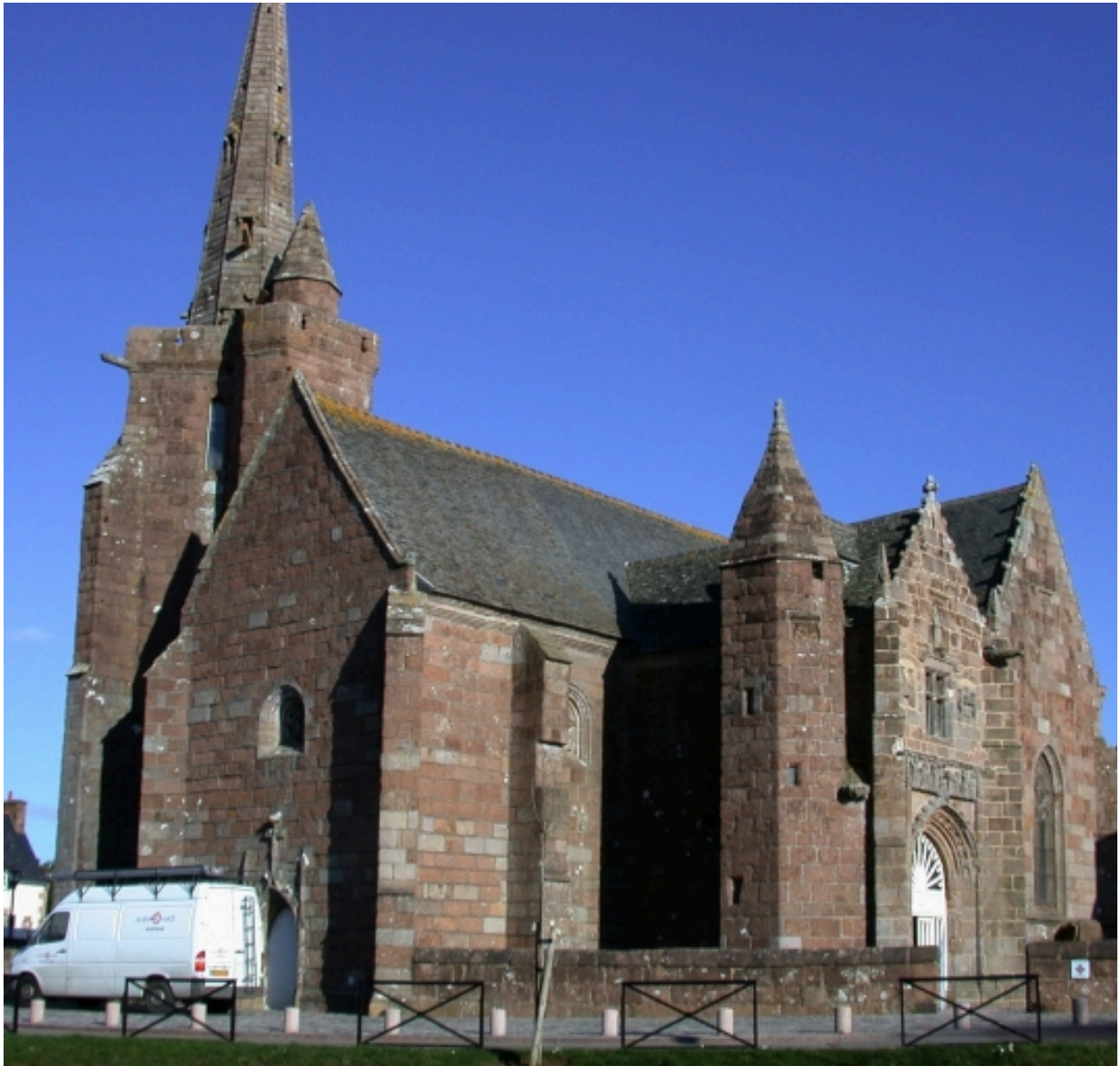
Vue générale (élévation sud-ouest)
