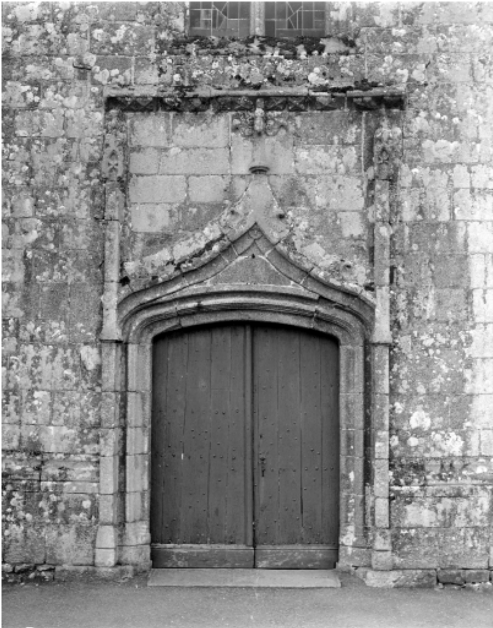
Elévation Ouest, porte principale : vue générale
