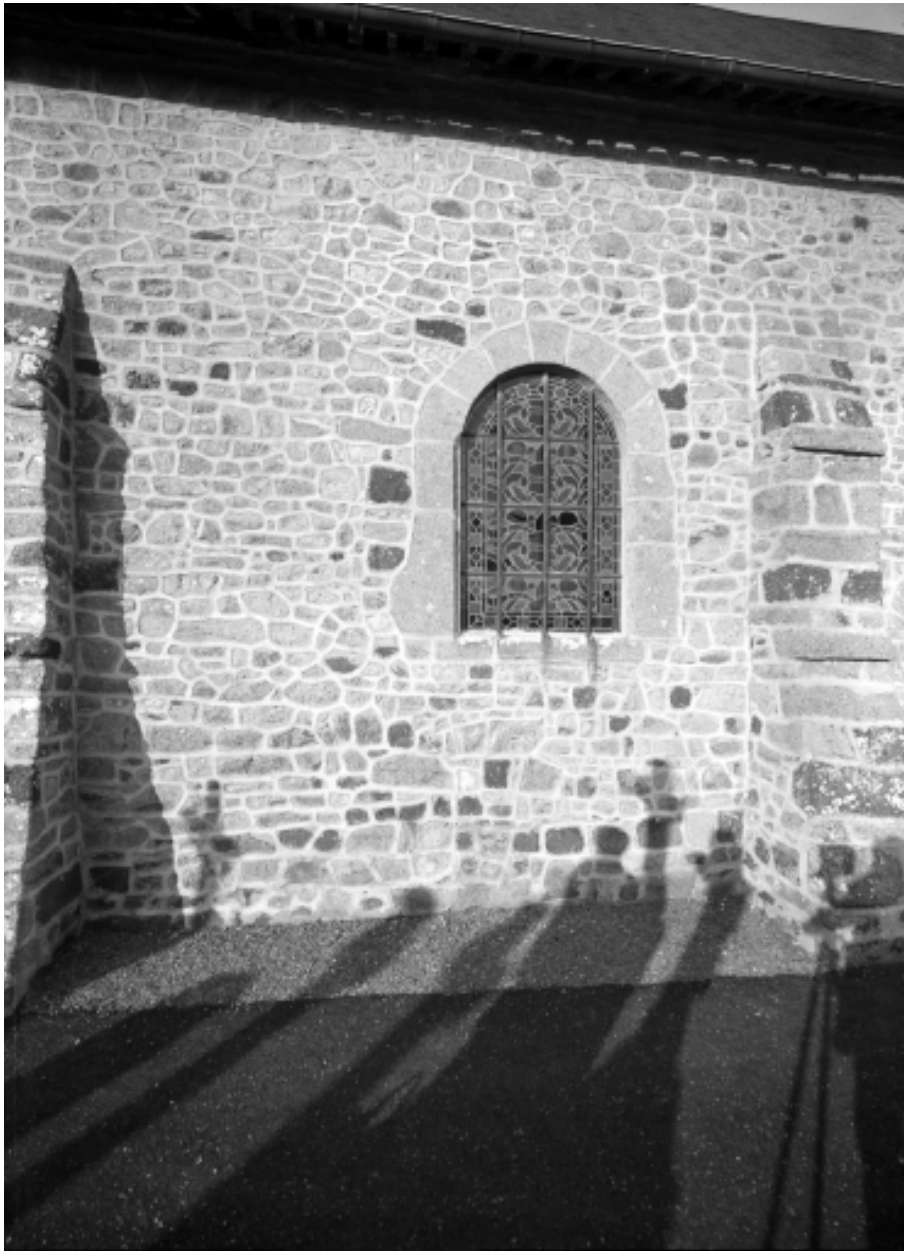
Elévation sud, fenêtre ouest : vue générale
