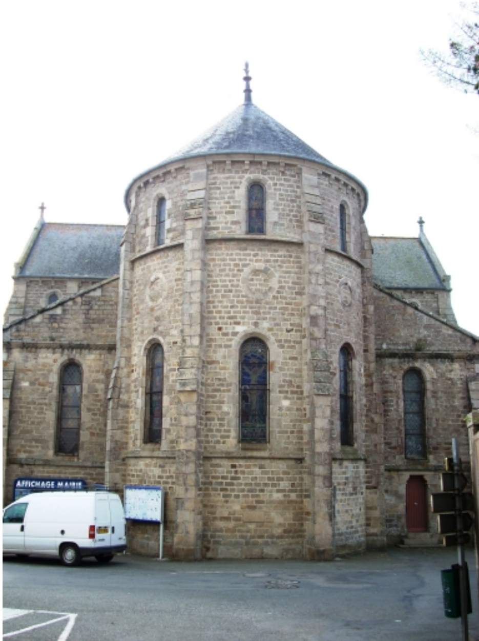
Lanmeur, église paroissiale Saint-Mélar : élévation est
