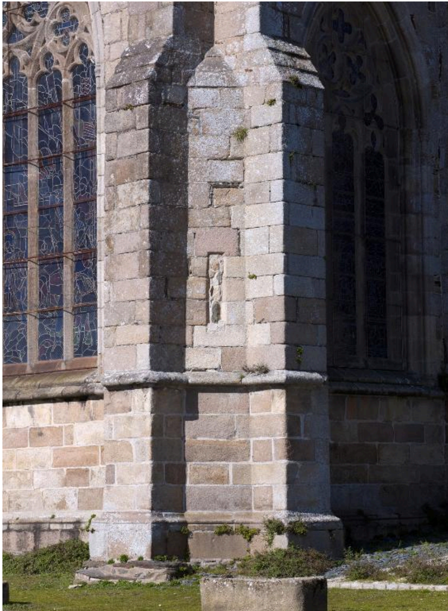
Chapelle sud. Contrefort sud-est. Détail d'un jour de tir bouché
