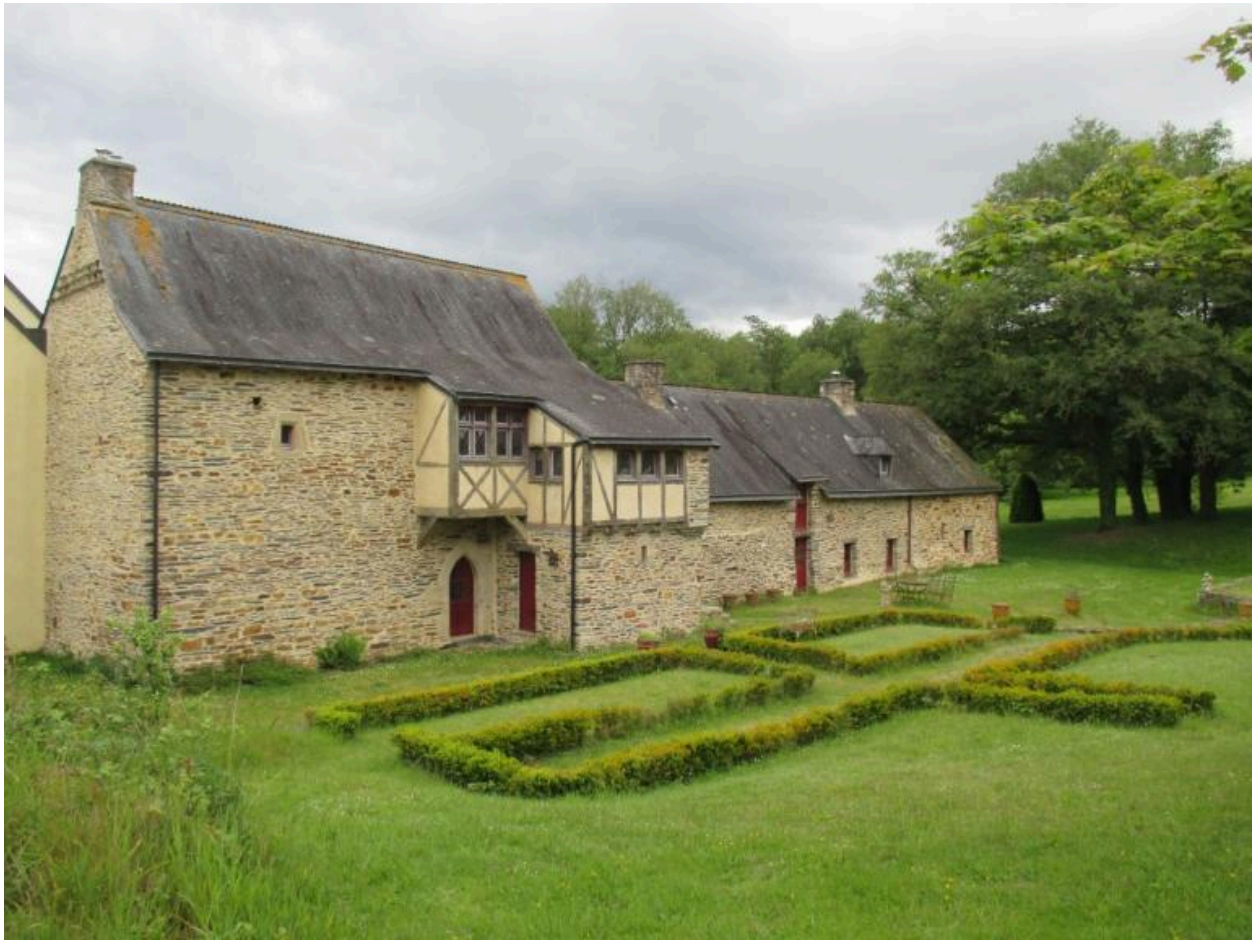
Façade nord, vue générale
