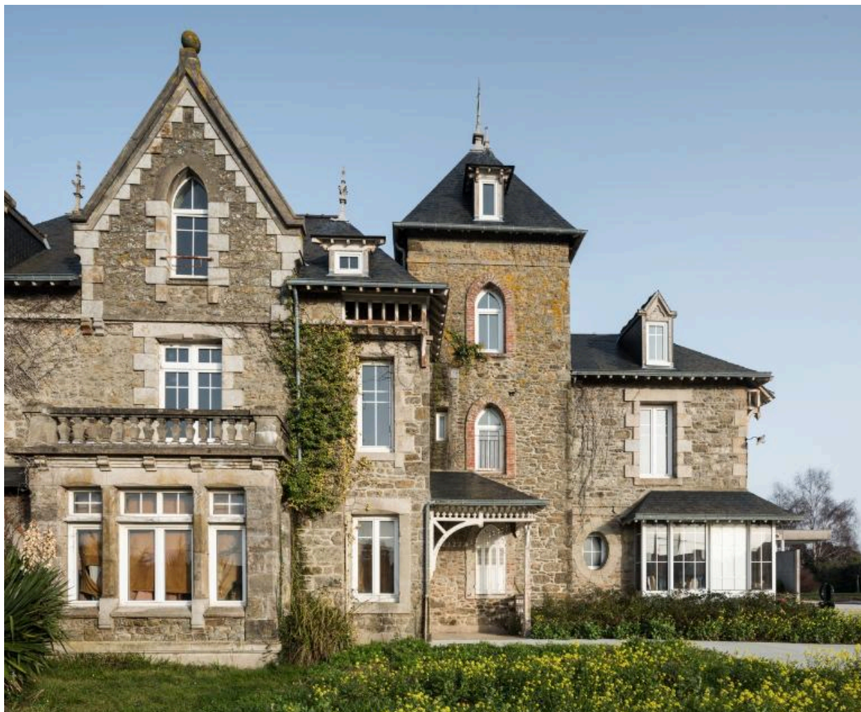
Façade ouest, vue de face
