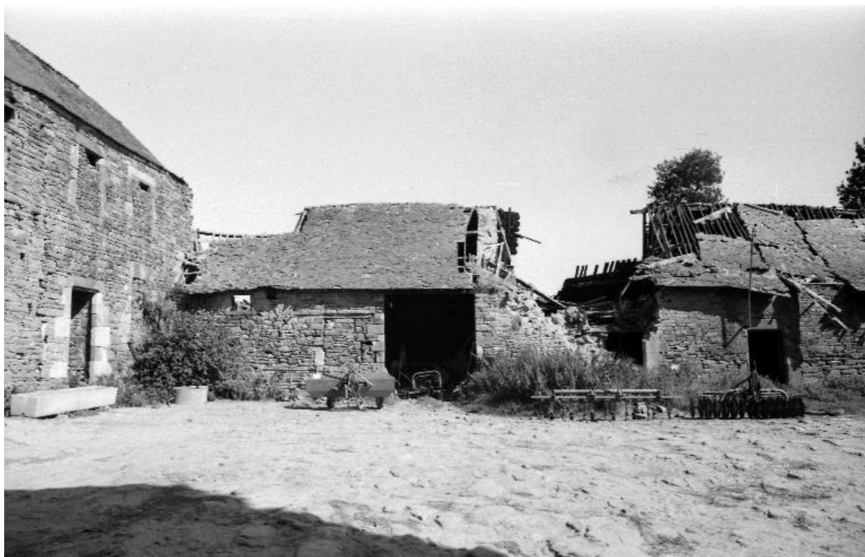
Communs : vue d'ensemble de la façade nord-ouest
