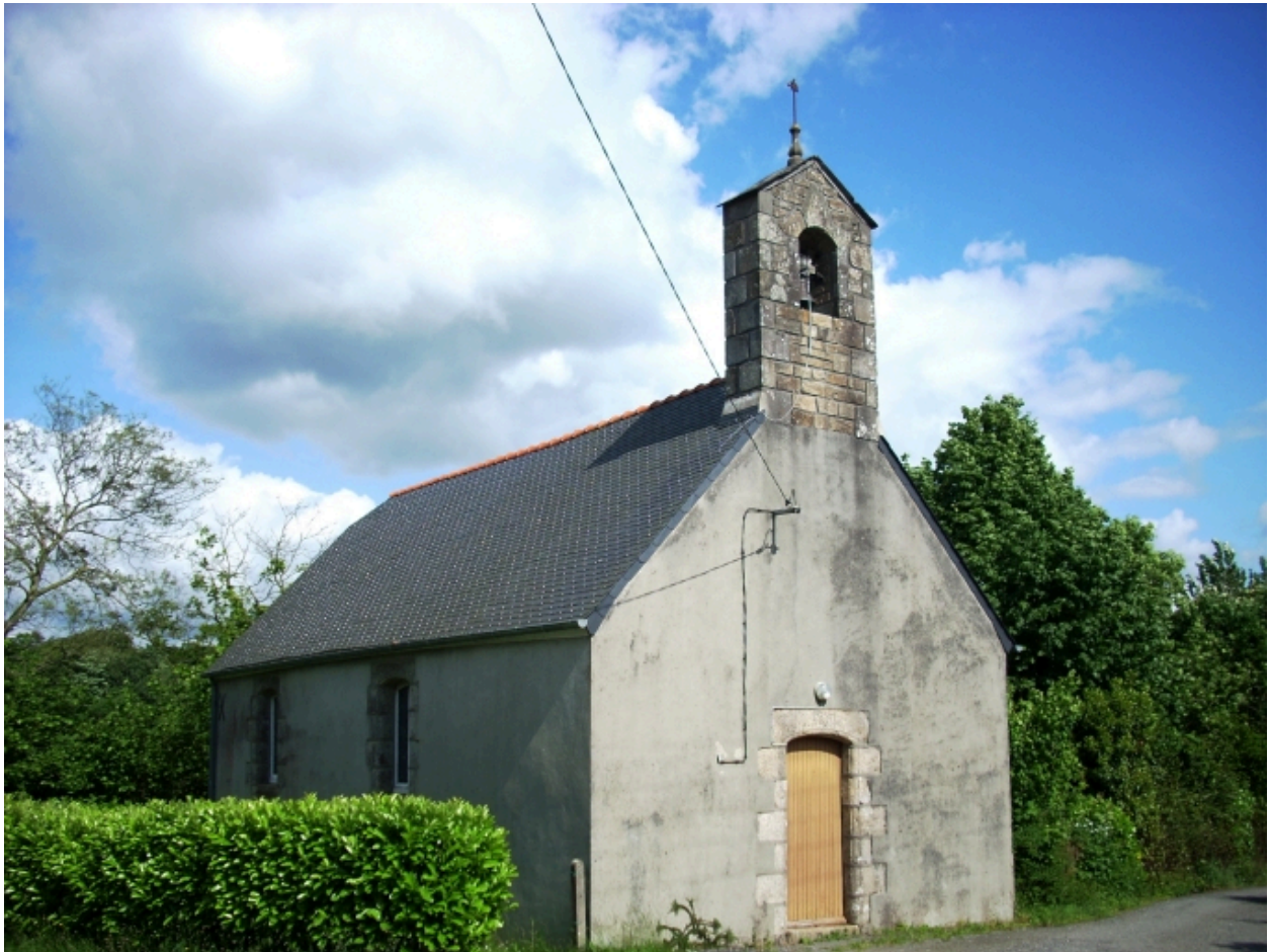
Chapelle Sainte-Anne : vue générale nord-ouest
