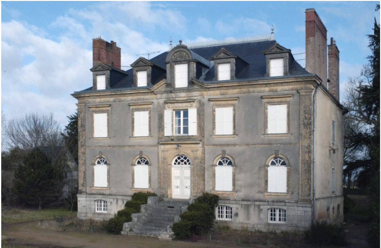
Vue générale de la façade principale
