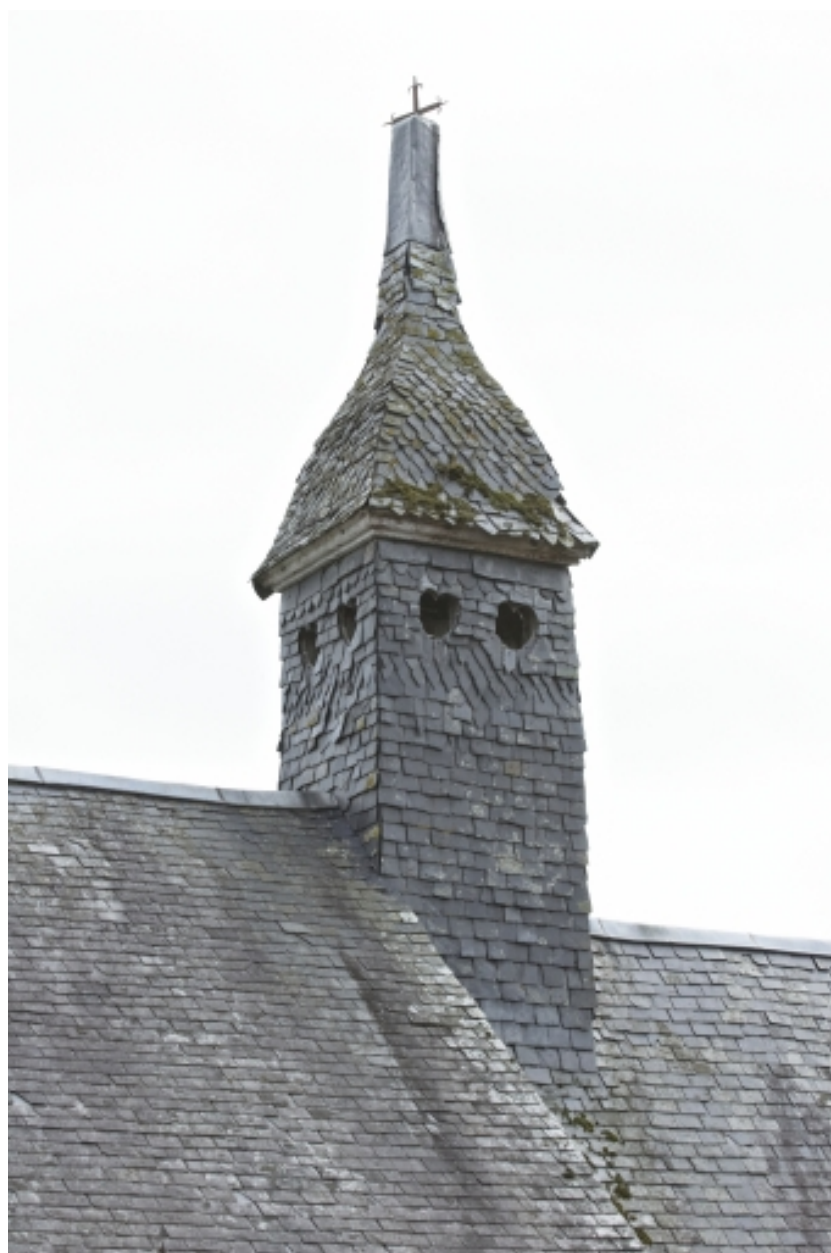
Chapelle, clocher de charpente
