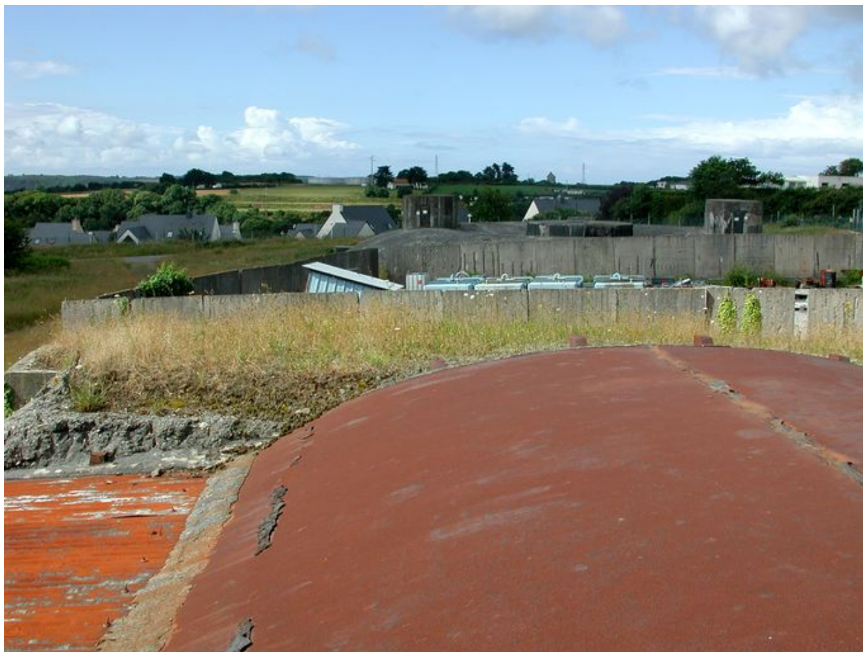
Vue du toit blindé (état en 2003)
