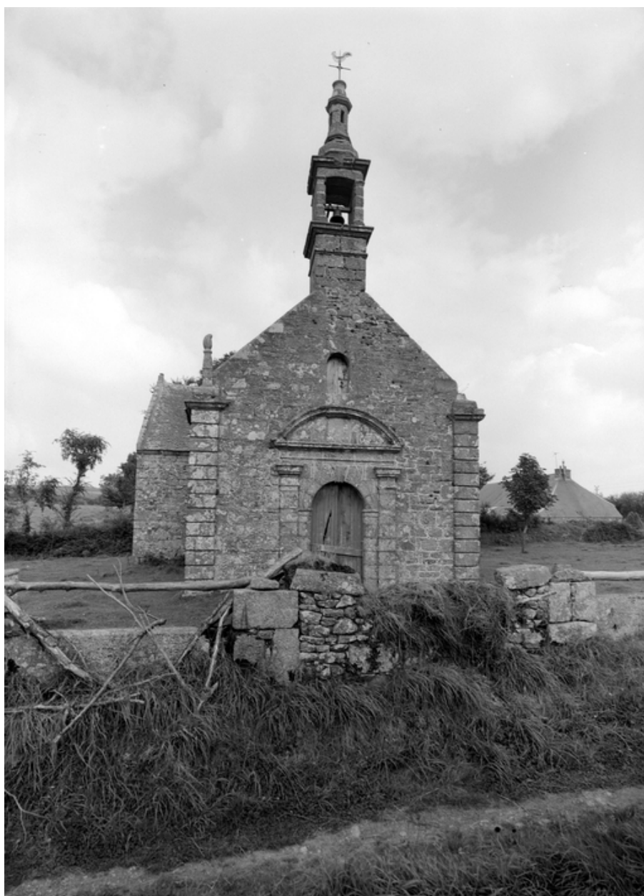
Vue de la façade ouest
