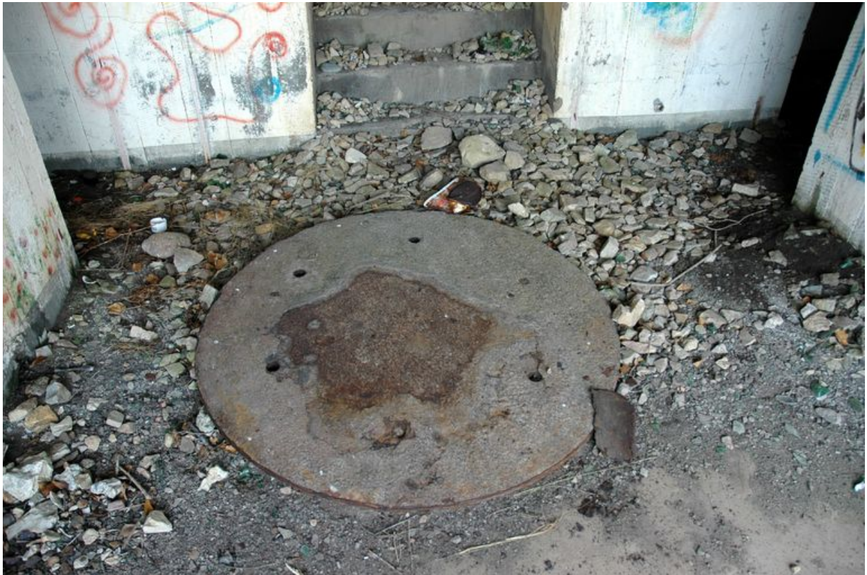
Vue de la chambre de tir de l'un des deux bunkers - casemates de type 671 (état en 2005)
