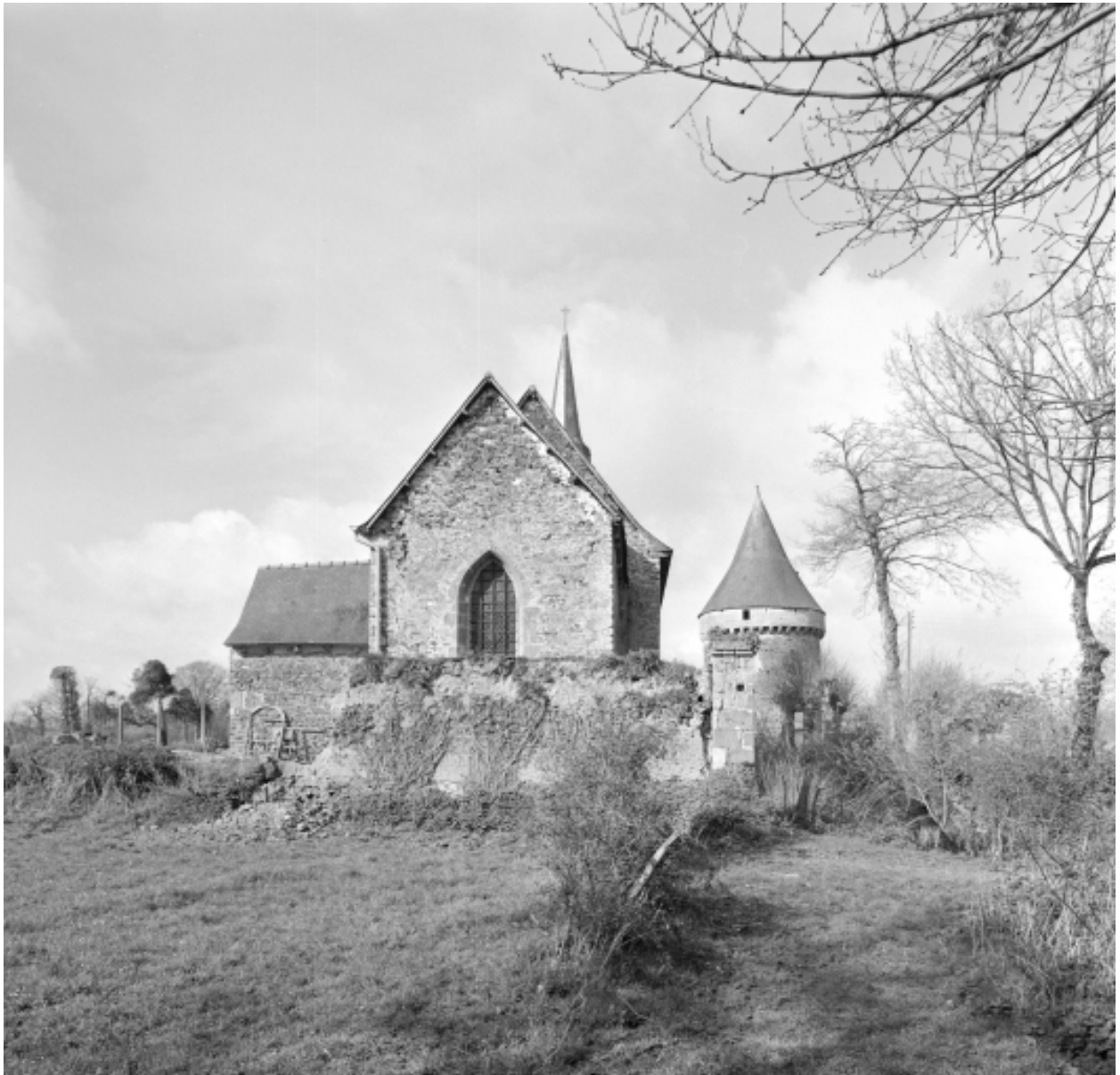
Elévation Est : vue générale
