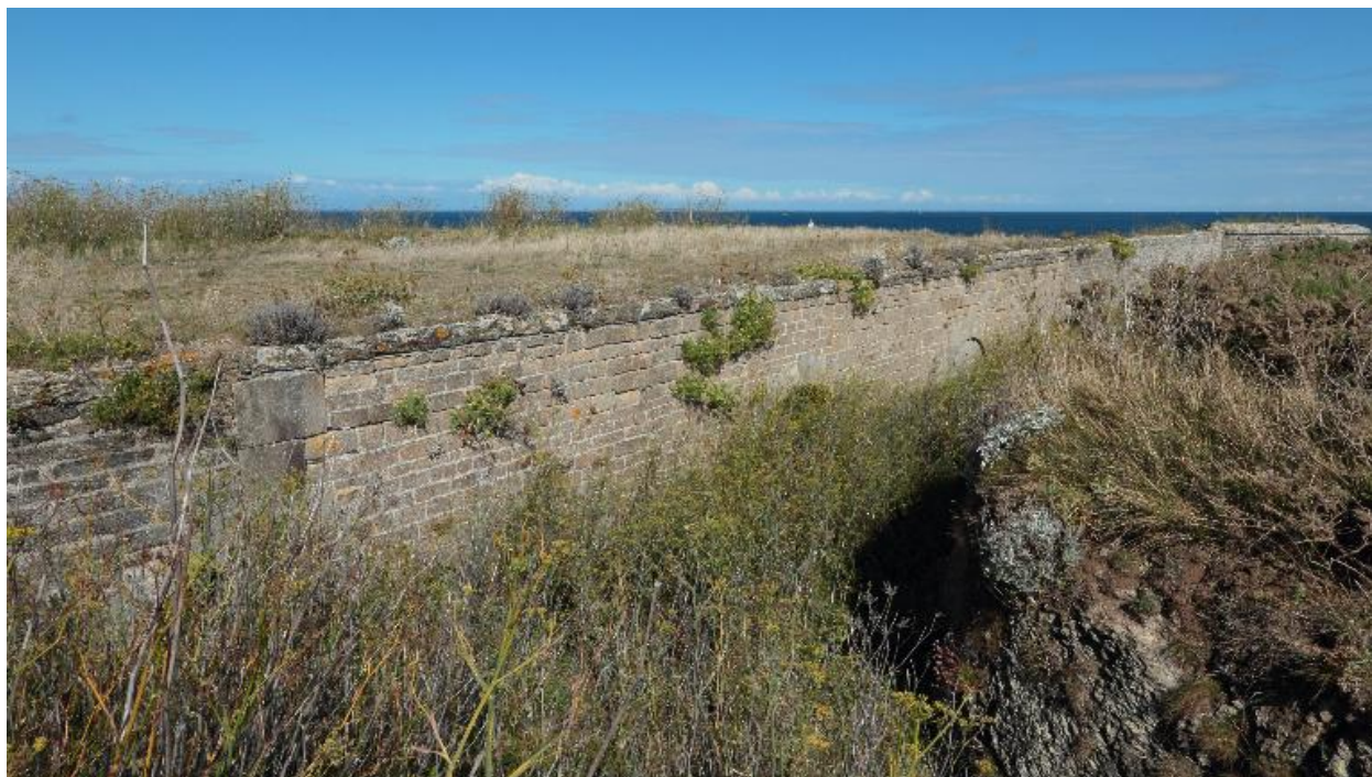
Le Palais, pointe de Taillefer, batterie de 1882, enceinte de gorge intégrant le corps de garde crénelé.
