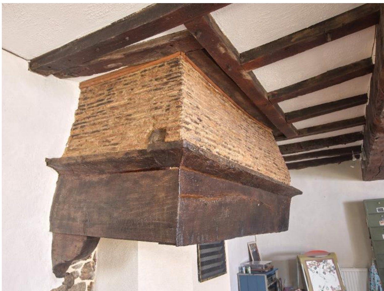
Logis principal. Salle. Cheminée sur le mur de refend. Détail du manteau en brique, du linteau et des retours en bois
