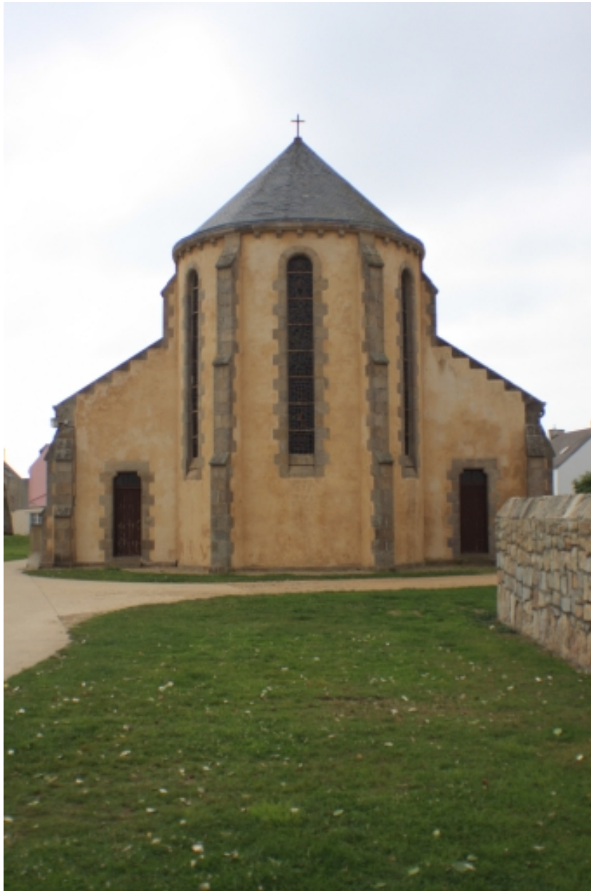
Île-de-Sein, église paroissiale Saint-Guérolé : élévation est
