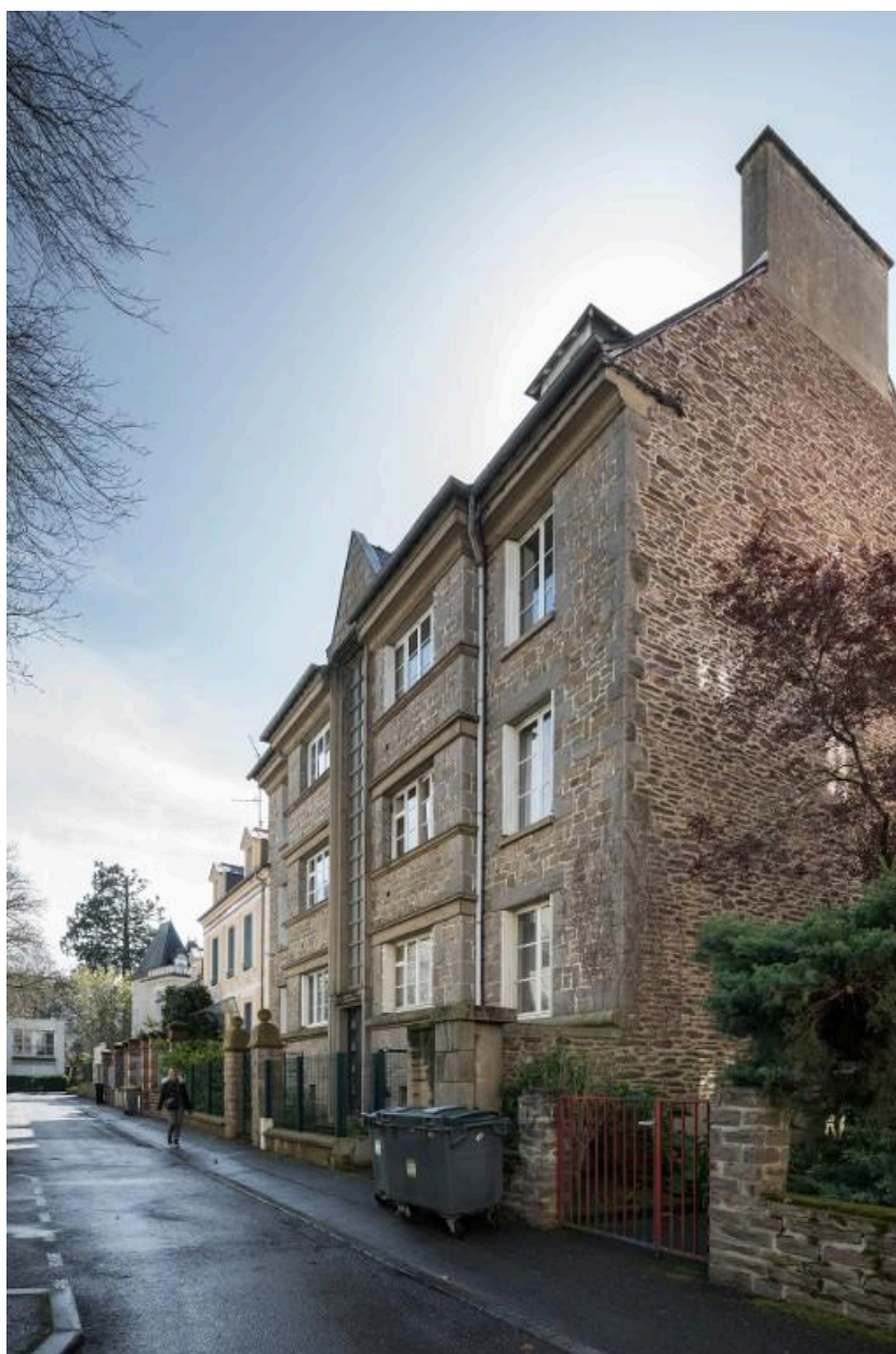
Vue du pignon ouest et de la façade nord.
