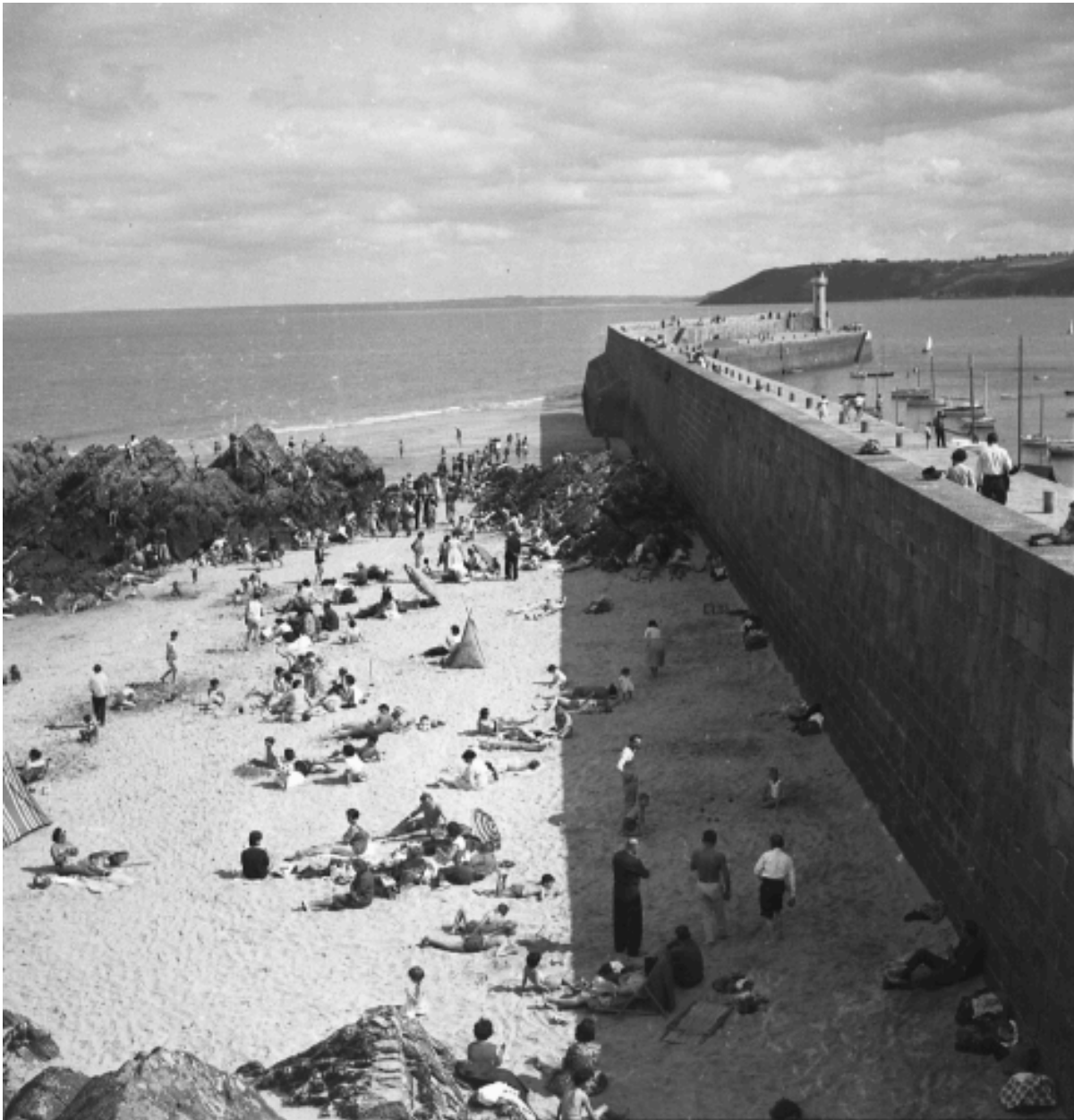
Vue du mur ouest du môle de Penthièvre : remarquer la forme du mur et le fruit prononcé de 10%, vers 1960-70 (AD 22)
