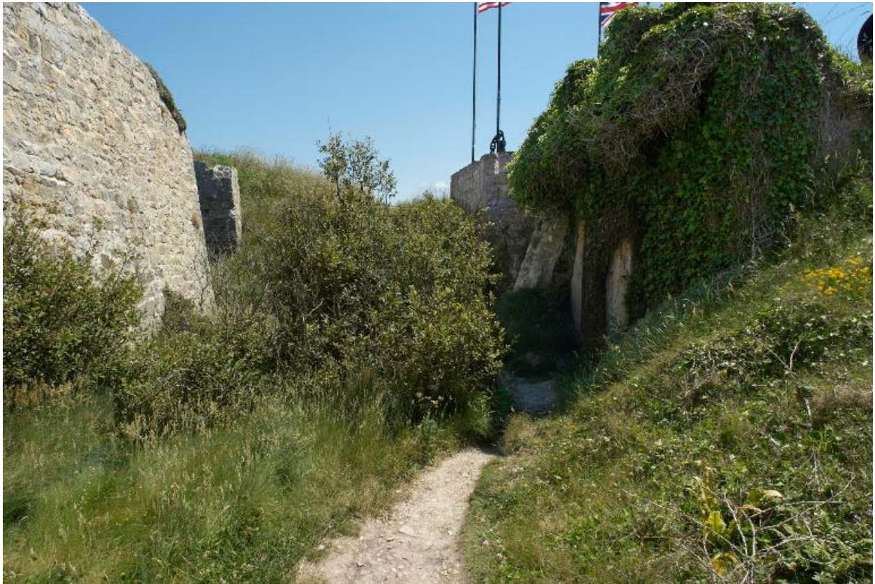
Vue du fossé de la batterie de mortier
