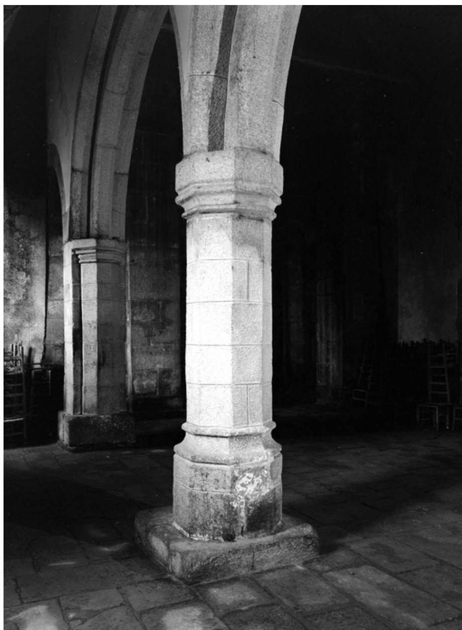
Nef : vue du pilier sud n°2
