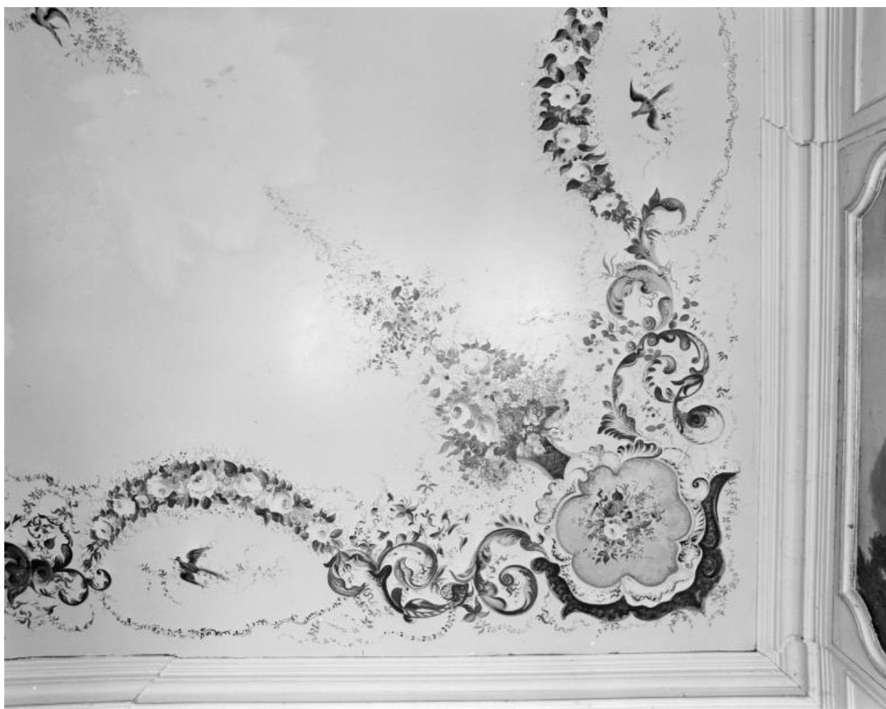
Château, rez-de-chaussée, pièce axiale : grand salon, plafond, angle, décor peint.
