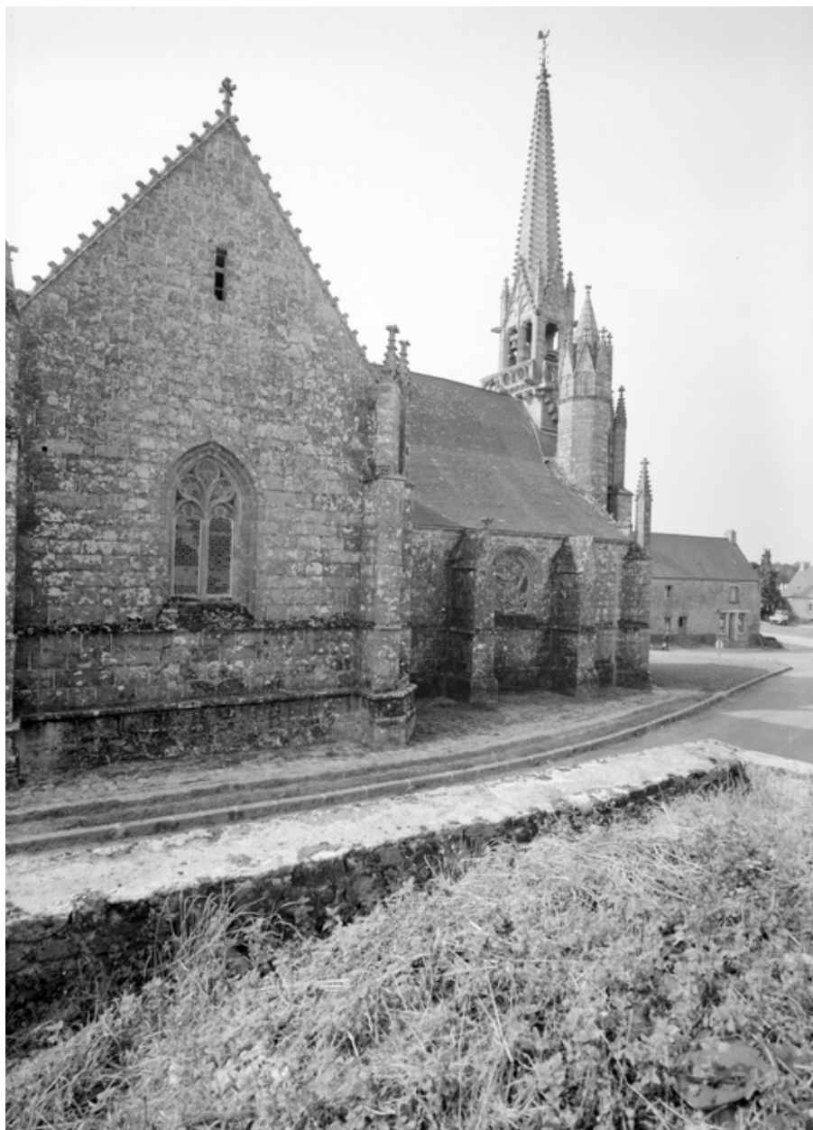
Mur nord de la nef.
