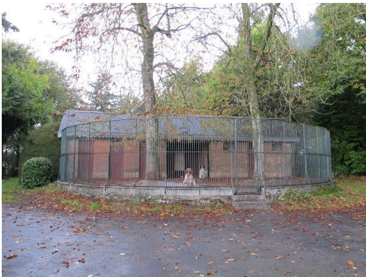
Chenil : vue générale
