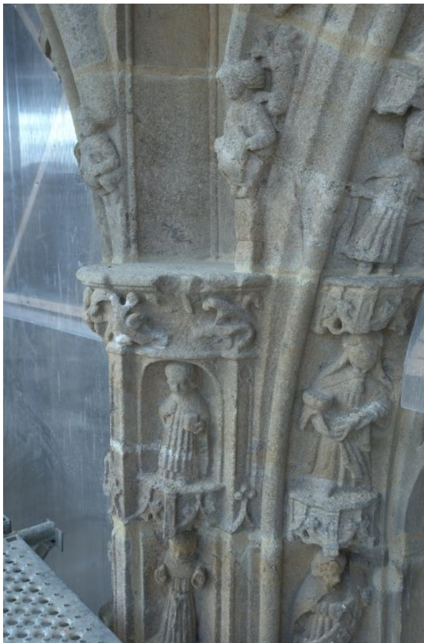
Portail nord, détail voissures des fenêtres
