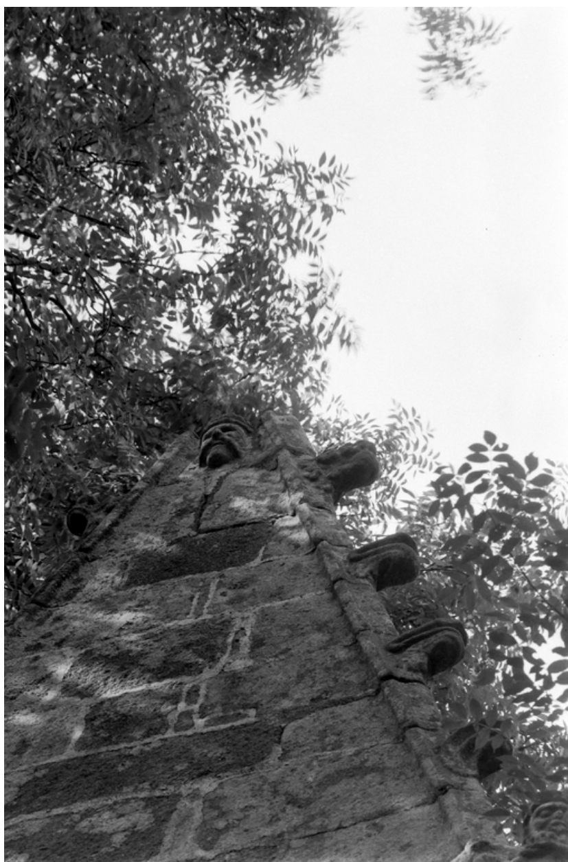
Pan central du chevet : vue du sommet du gâble
