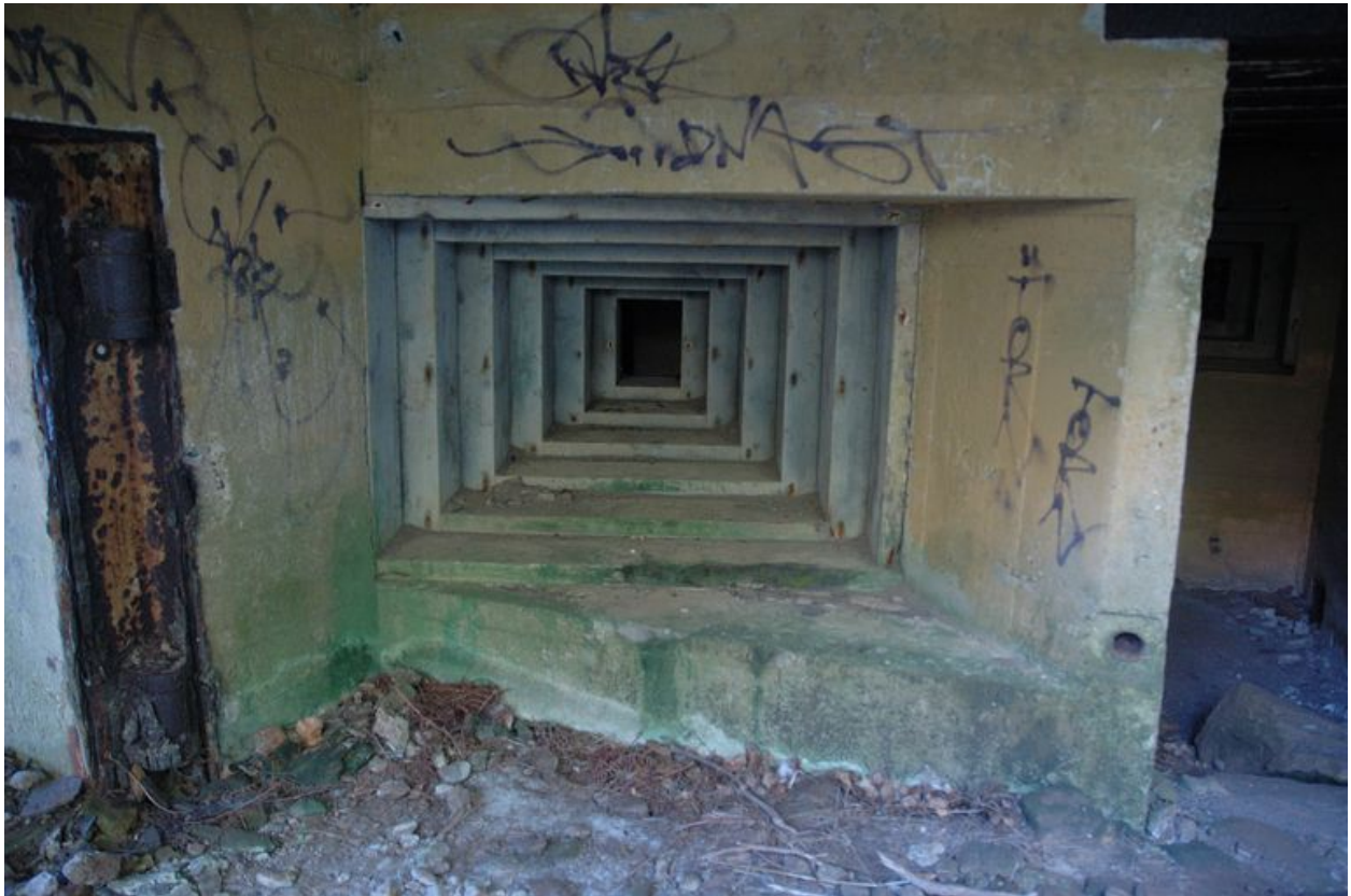
Vue de l'ensemble fortifié d'Illien (Stützpunkt Kerlouchouan) (Re 38, 39, Re 99-103, Re 124) : casemate de type 505 pour canon anti-chars
