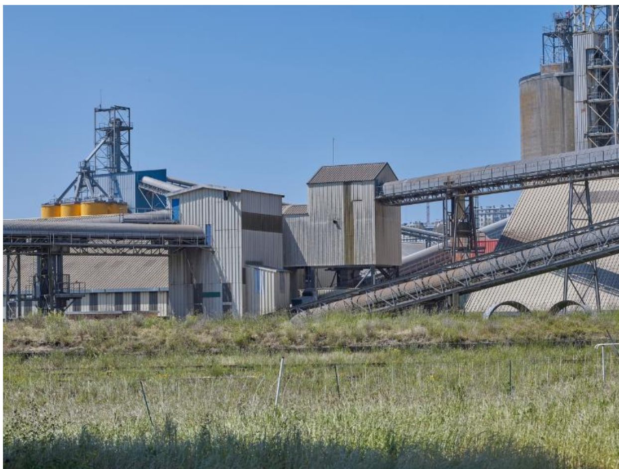
Entrepôts, silos, tour de liaison et bandes transporteuses
