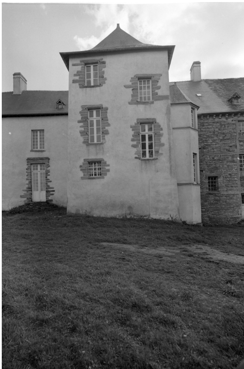
Tour façade nord, vue générale.
